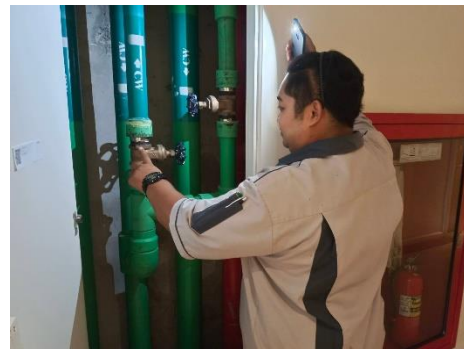
รูปที่ 15 เจ้าหน้าที่ตรวจสอบรอยรั่วของท่อระบายน้ำ
